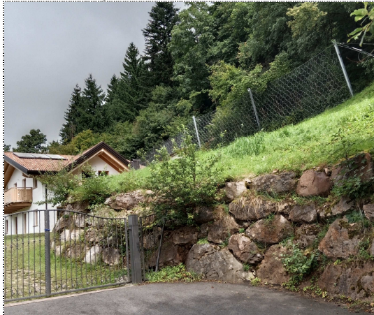
La barriera paramassi esistente vista da Sud
