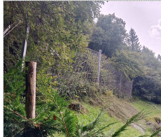
La stessa vista da Nord
