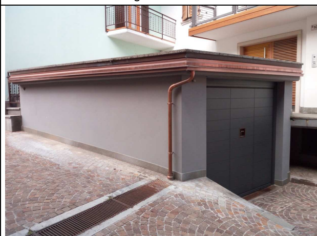
Costruzione accessoria con copertura in lamiera
