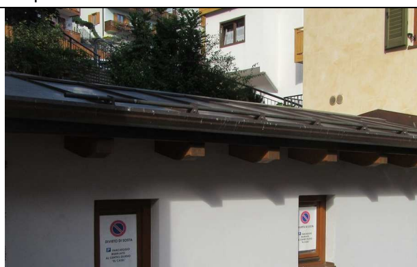
Copertura in lamiera di costruzione accessoria con falda in bassa pendenza.
