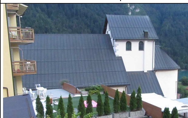
Copertura in lamiera della chiesa
