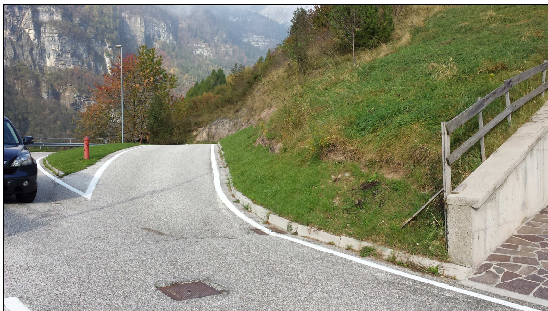
Foto 3: La nuova strada consortile al confine con l'area di progetto
