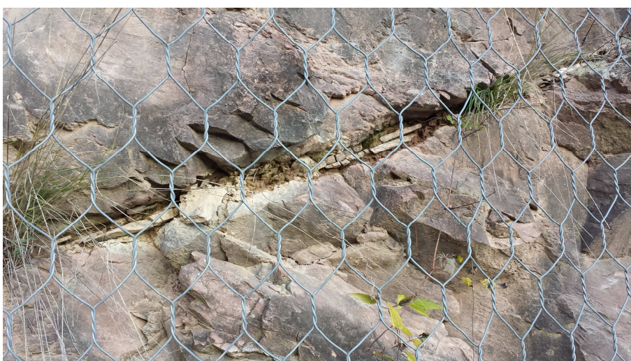
Figura 21. Particolare del riempimento di una frattura ( 360^{\circ}/32^{\circ} ) in stazione 2
