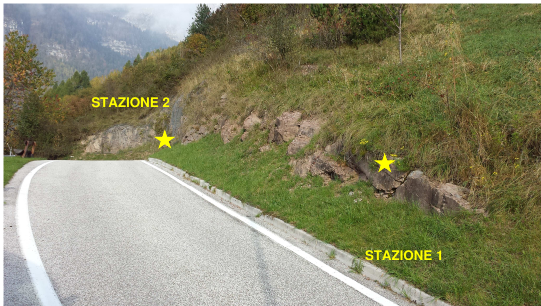
Figura 18. Ubicazione delle stazioni di misura strutturale
